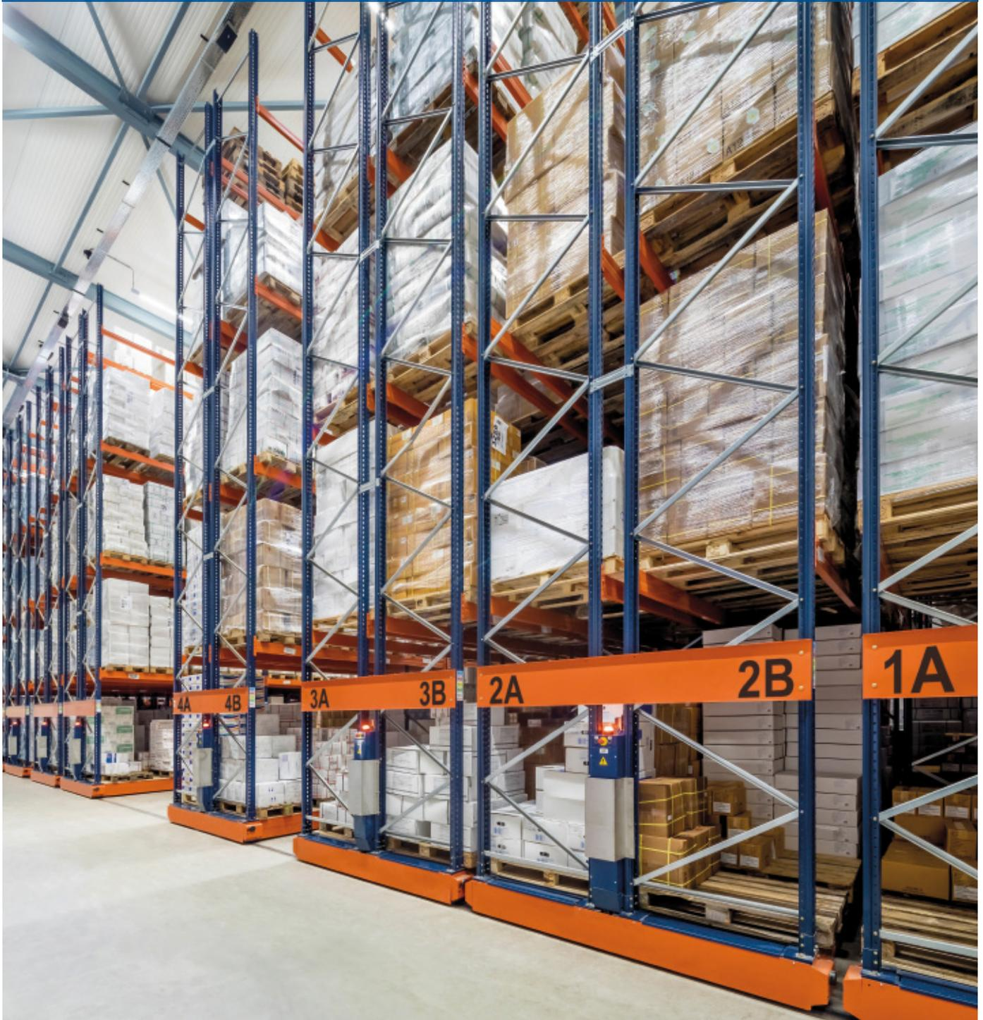
Das niederländische Fischereiunternehmen Mooijer-Volendam B.V. hat eines seiner Tiefkühlager mit Movirack-Verschieberegalen von Mecalux ausgestattet. Die Regalanlage nutzt die gesamte Lagerfläche optimal aus und bietet eine Lagerkapazität für bis zu 4.349 Paletten.
