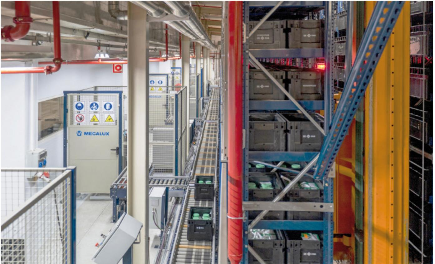
**Es wurden insgesamt neun Hubsysteme installiert, die beide Ebenen des Zentrums verbinden, die in einem Abstand von 4,47 m Höhe angeordnet sind. Sieben von ihnen verbinden die Produktionslinien mit dem automatischen Lager und die anderen beiden befördern die Ware zur unteren Ebene, in der sich der Lade- und Versandvorbereitungsbereich befindet.**
