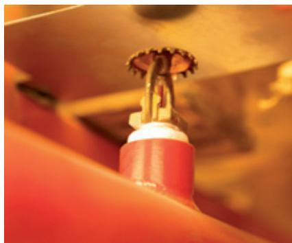
Die automatischen Sprinkler (Sprinkleranlagen) sind in Abhängigkeit von der Brandlast auf strategische Weise im Inneren der Regale verteilt.
