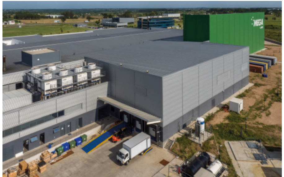
Die Rampen zur Be- und Entladung sind getrennt, um eine Überschneidung beider Vorgänge zu vermeiden
